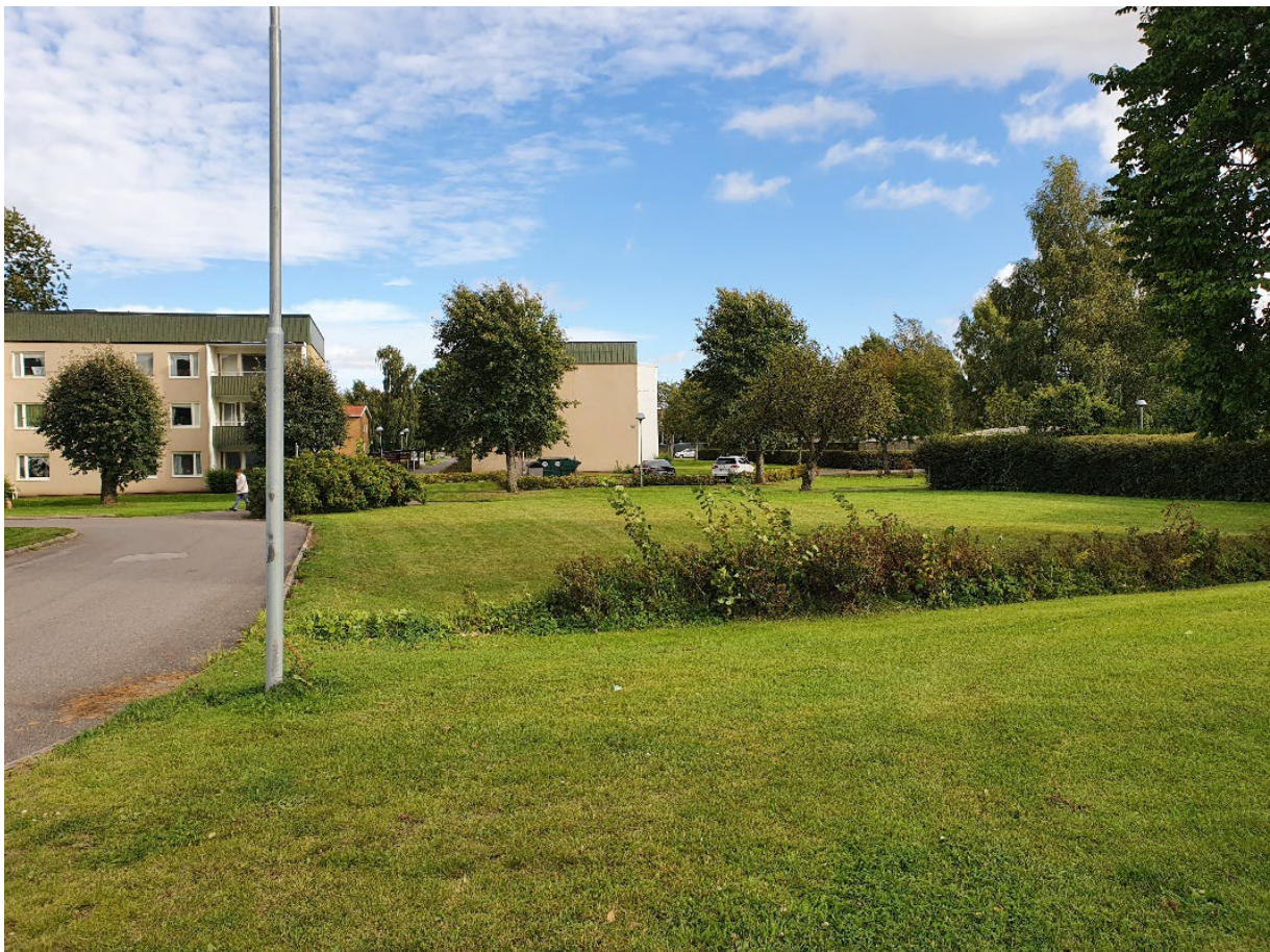
Bild 6: Den norra delen av planområdet mot Nordfalegatan. I förslaget ovan uppförs en mindre länga radhus eller ett mindre flerfamiljshus på platsen.
