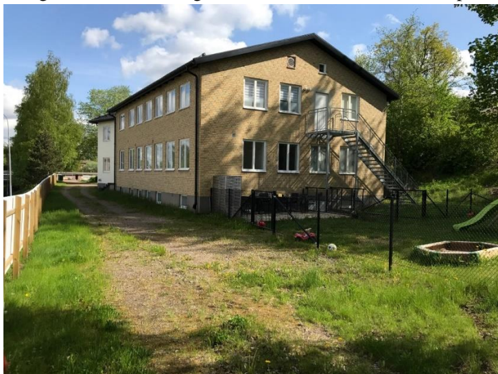
Figur 6 visar bebyggelsen inom fastigheten. Bilden är tagen från den sydvästra delen av tomten.
