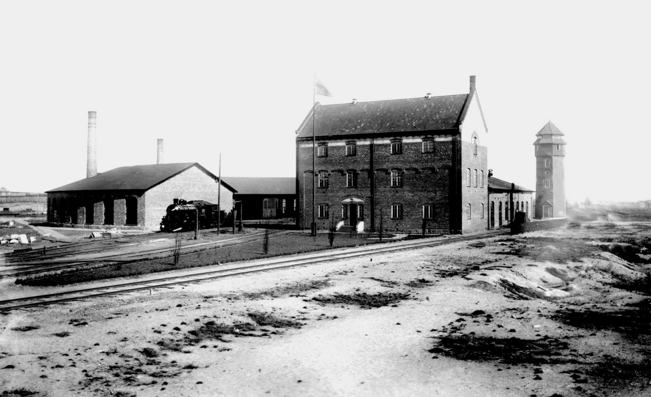
Nya lokstallarna, byggda mellan 1906-12, finns fortfarande kvar. Här håller bl.a. Svenska Motorvagnsklubben till.
