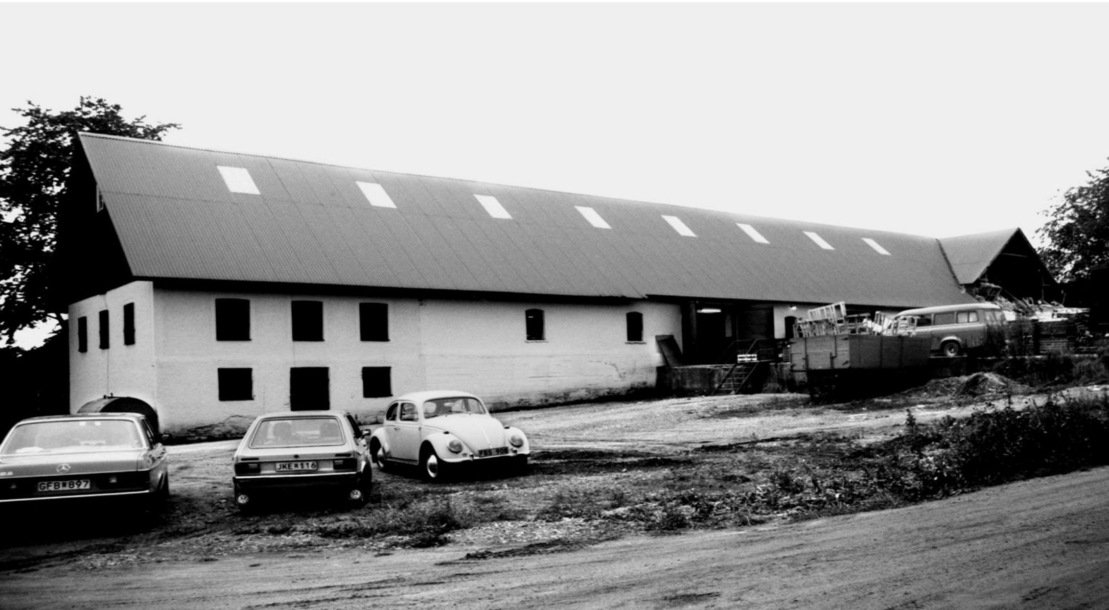
Rantens ladugård, fotograferad i samband med rivningen i september 1987.
