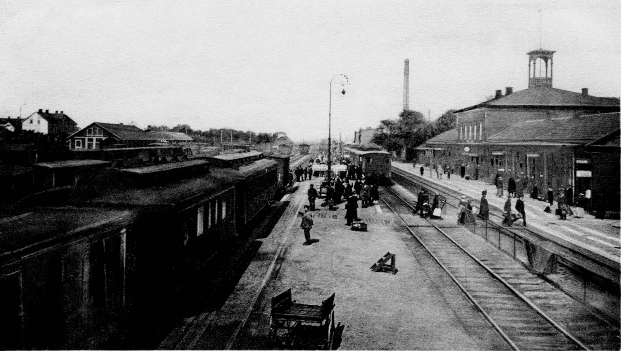
N:o 177. Falköping—Ranten. Järnvägsstationen.
