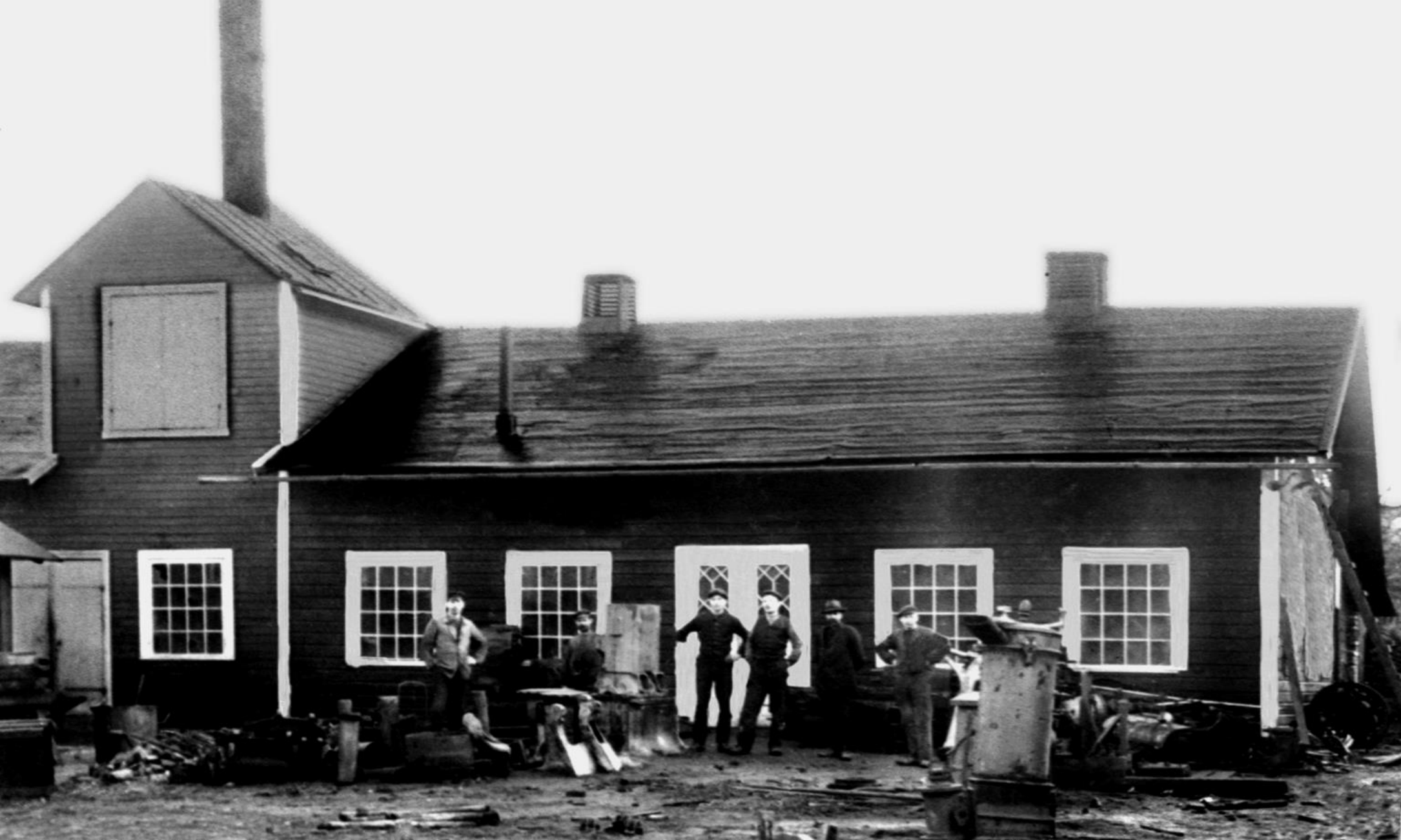
Nils Nilssons gjuteri. Det första gjuteriet byggdes 1909 och blev kvar till 1911 då det nya gjuteriet var byggt tvärs över gatan. Denna byggnad användes sedan av Falköpings likkistfabrik.
