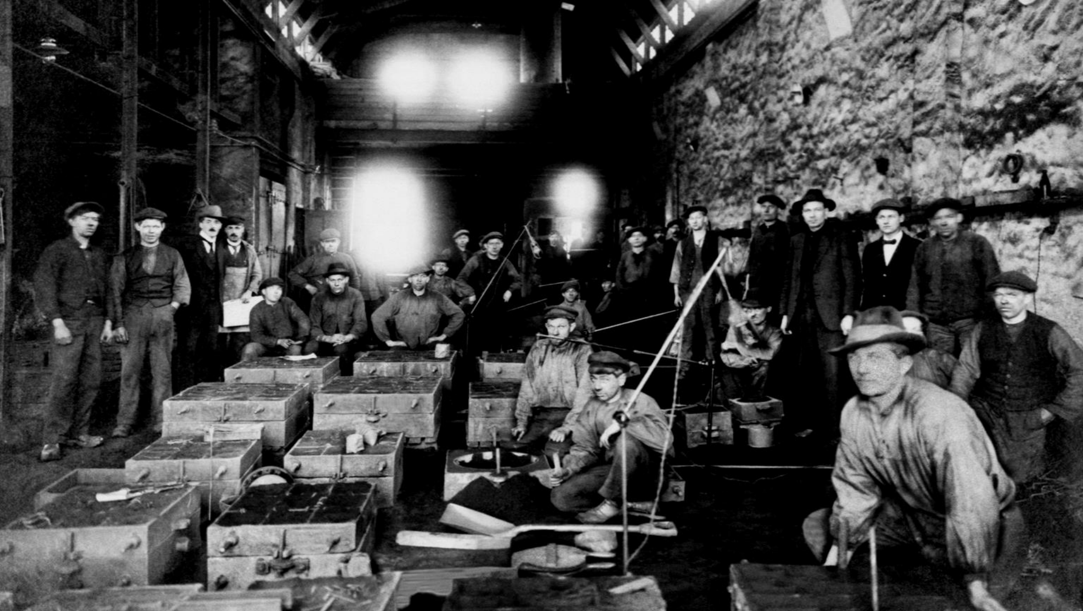
Nils Nilssons gjuteri. Interiörbild från gjuteriet. Längst bak uppe på balkongen matade man ugnen med järnskrot och övriga tillbehör som smältes samman. På jordgolvet står formarna som järnet hälldes i. Tre män hjälptes åt att bära varje s.k. flaska som innehöll det flytande järnet. Mannen i hatt till vänster i bild är Nils Nilsson.
