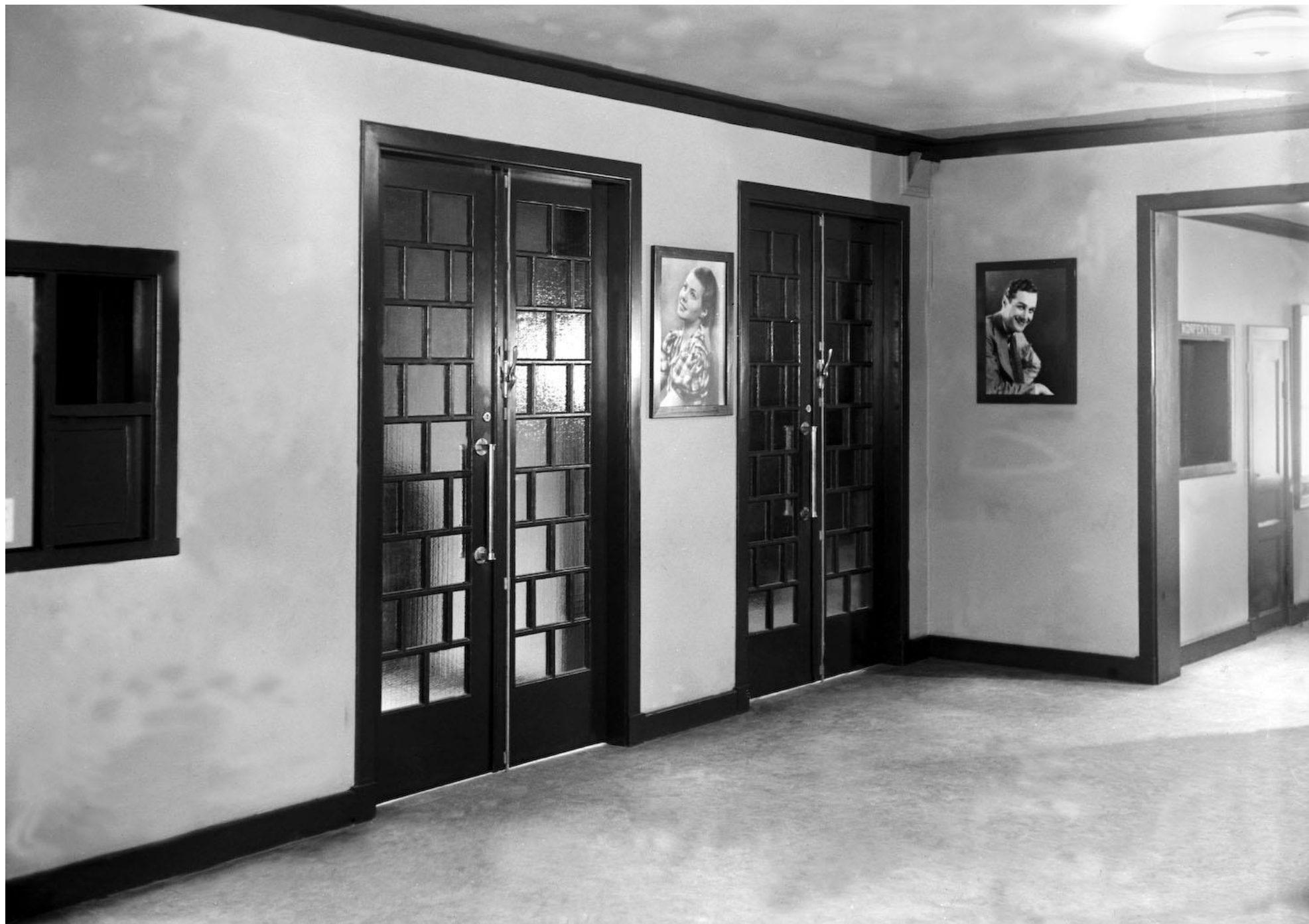
I foajén, foto troligen 1935.
