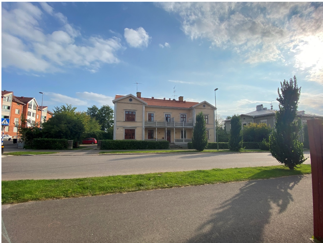
Bild 25 visar huvudbyggnaden på fastigheten Veterinären 1 ifrån norr.
