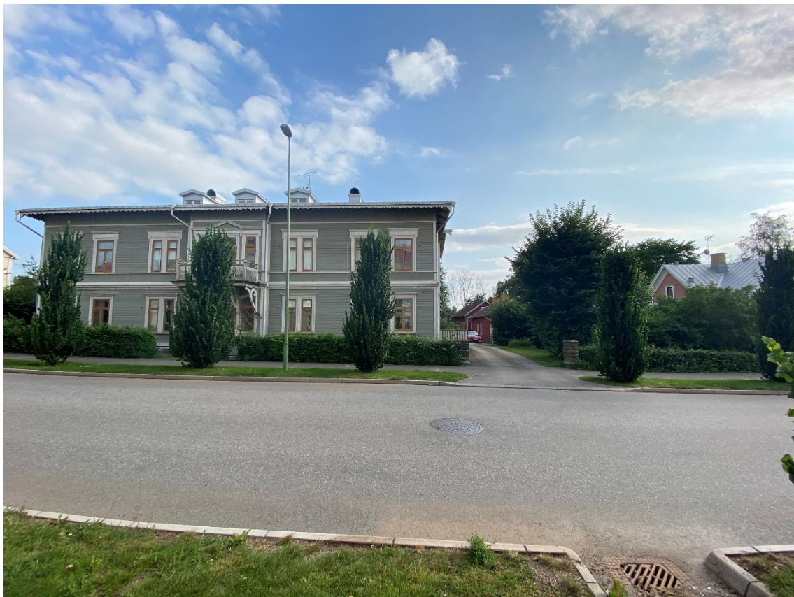
Bild 26 visar huvudbyggnaden på fastigheten Veterinären 2 ifrån norr.
