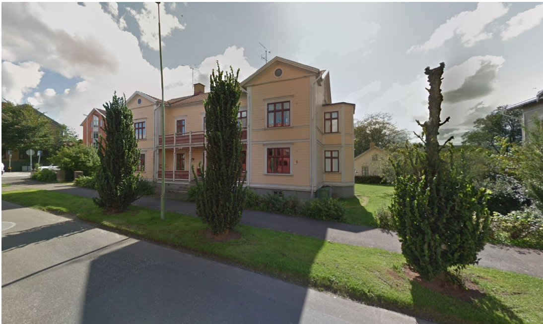
Bild 8 visar huvudbyggnaden på Veterinären 1 som har ett regionalt bevarandevärde.
