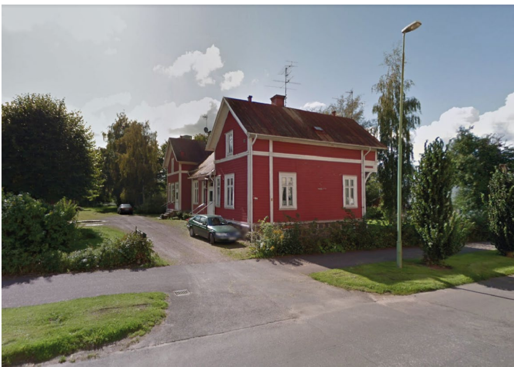
Bild 14 visar huvudbyggnaden på Veterinären 15 som har ett regionalt bevarandevärde.
