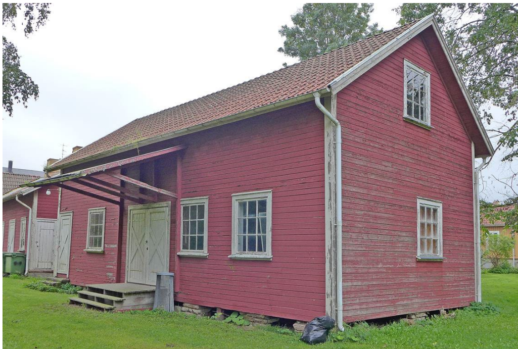
Bild 16 visar det södra uthuset på fastigheten Veterinären 15. Foto: Ulf Larsson
