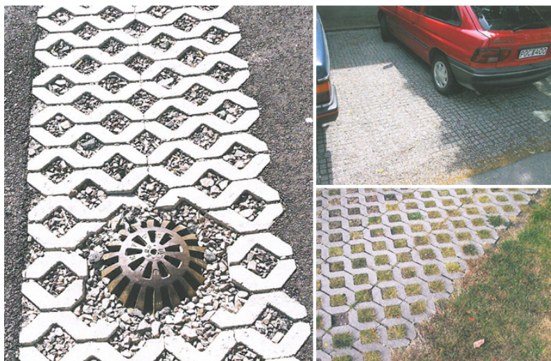
Figur 24 visar ett antal exempel på ytor som inte ska räknas som hårdgjorda ytor 4
