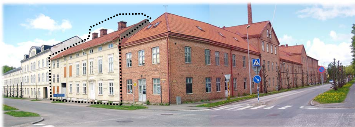
Träbyggnaden på Fabrikören 12 mot Trädgårdsgatan
