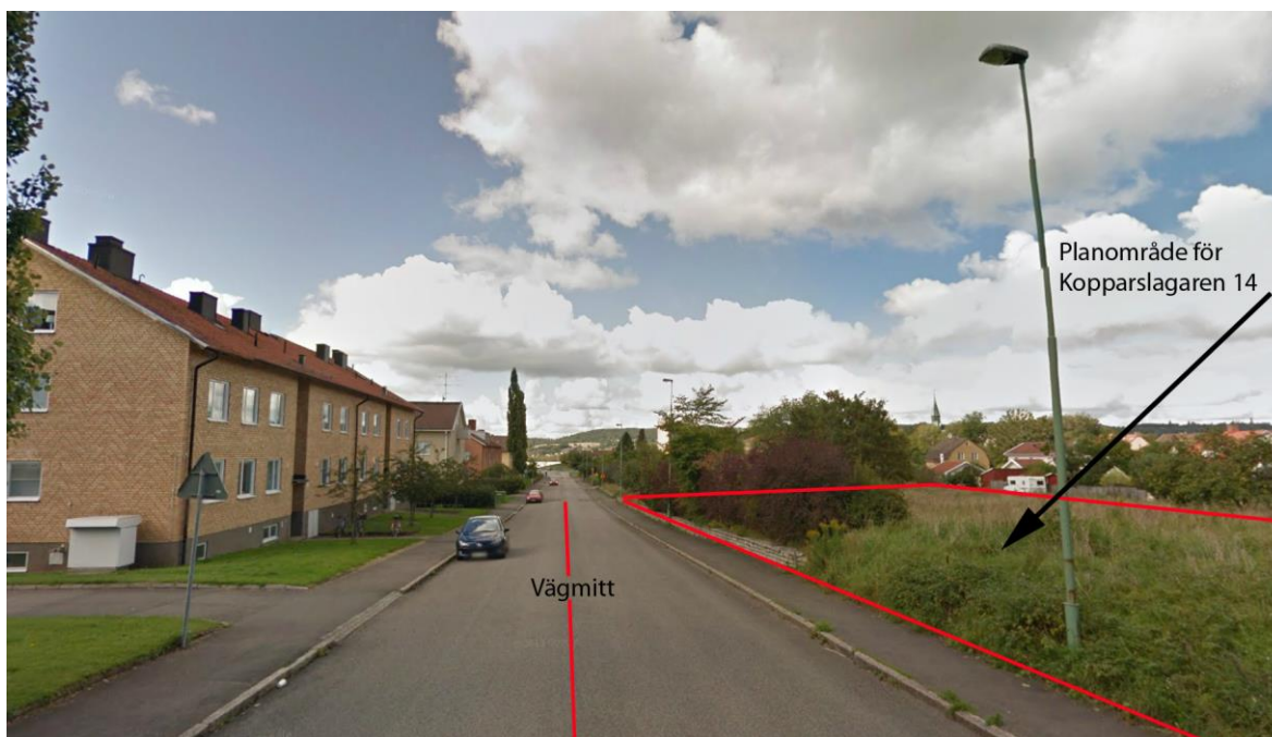
Bild 14, visar Hwasssgatan och planområde för Kopparslagaren 14 på höger sida. Byggrätten på tomtmark är begränsad till minst fem meter innanför planområdesgränsen, totalt minst 14 m från vägmitt.
