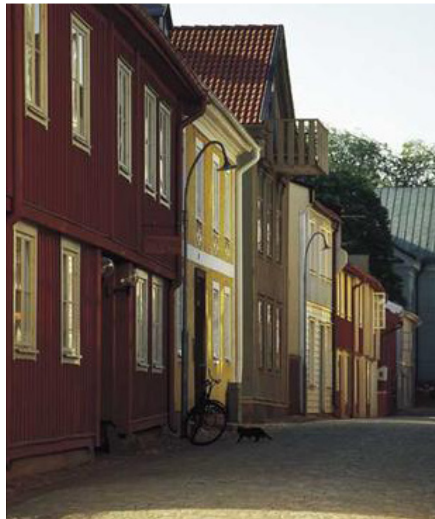
Det är viktigt hur man bevarar en befintlig karaktär, stadsutveckling i kulturmiljö är känsligt, bild från Eksjö.
