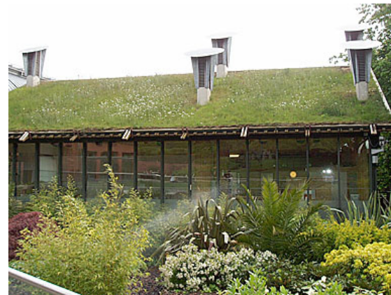
Modern byggnad med ekologiskt uttryck i Kv Snickaren
