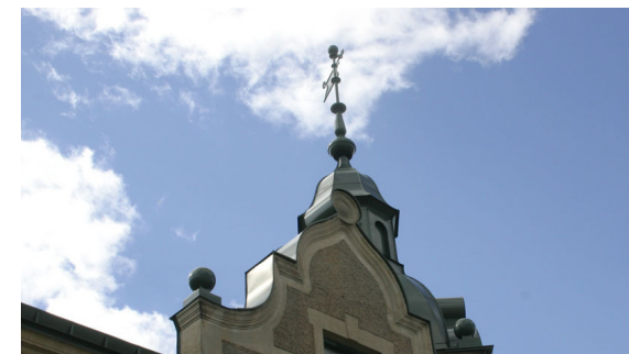
Tinnar och torn präglar taklandskapet på stenhusbebyggelsen vid korsningen Storgatan och S:t Olofsgatan.
