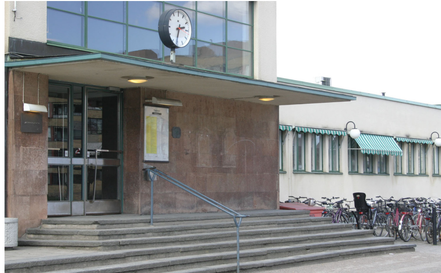
Sveriges enda funktionalistiska stationsbyggnad finns i Falköping uppförd 1935.
