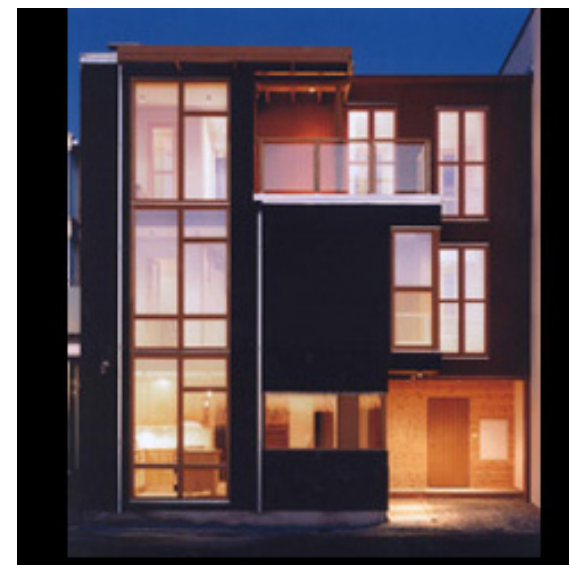
Det är viktigt att bereda plats för moderna tillägg i stadens utveckling, Rödfergspriset Wingårds arkitekter.
