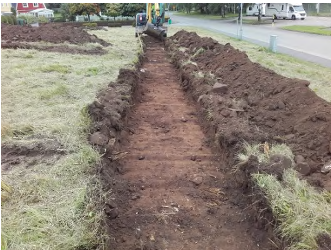
Fig. 4. Översikt schakt 100, närmast vägen. Foto från öst.
