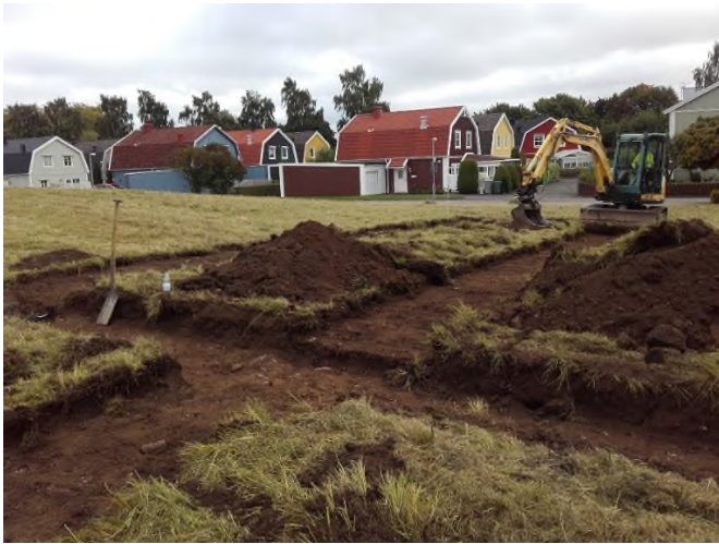
Fig. 3. Översikt sökschakt. Foto från sydväst.
